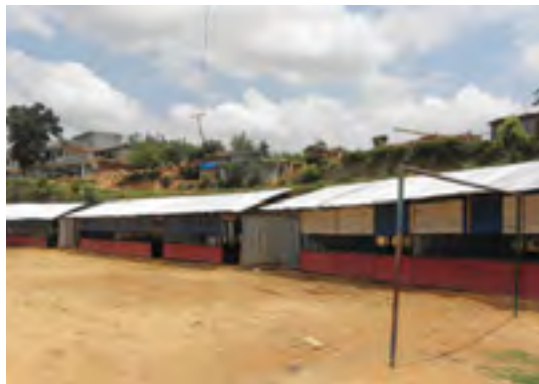
Provisorische neue Gebäude in Sangachok
