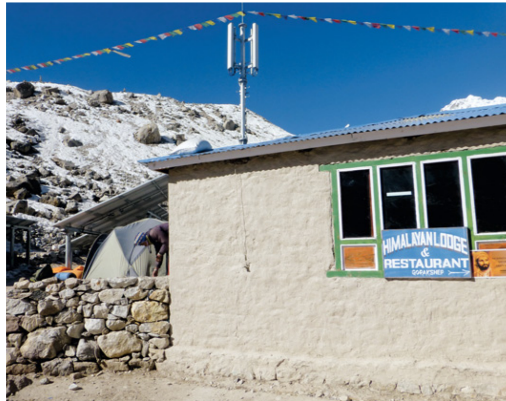
Mobilfunk-Mast in Gorak Shep unweit des Basislagers auf der Südseite des Mount Everest
